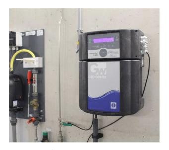
Der **Testomat**® **EVO TH CAL** wird bei Kunden von Geonwater B.V./Niederlande für die Messung der Wasserhärte eingesetzt. Sie schätzen besonders die Kalibrierfunktion des Gerätes.
